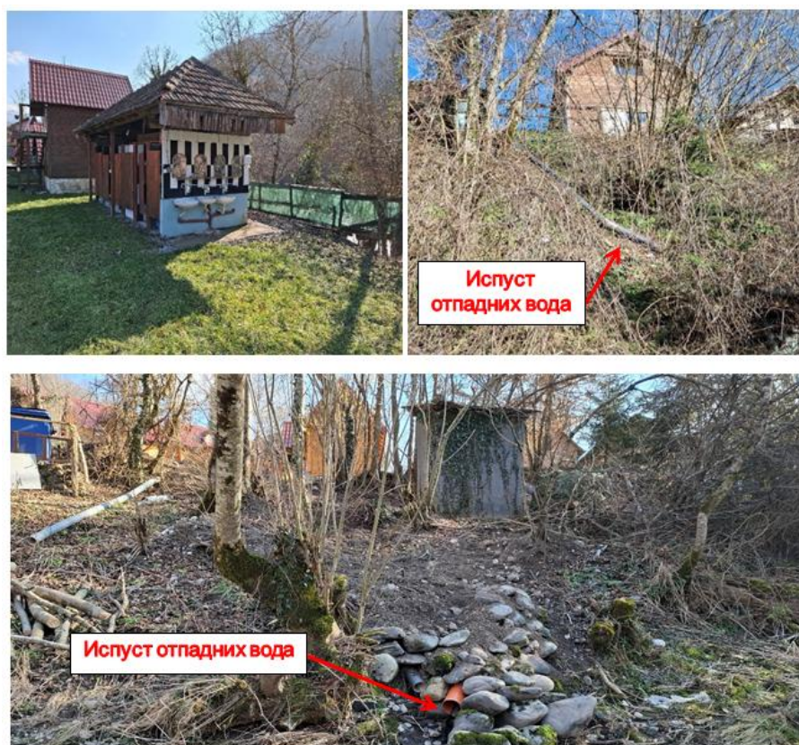
Слика 2.1.11.3.9. Типични типски објекти испуста отпадних вода директно у ријеку Дрину на локалитетима рафтинг кампова – Фото записи 04.02.2025. постојеће стање
