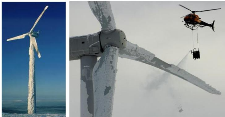
Слика 2.7.2.1. Залеђени вјетрогенератори током дугих периода нерасположивости због антициклона и врло ниских температура. Коришћење и хеликоптера за одмрзавање. САД, Илиноис, географске ширина сјеверно око 45 степени. 37
