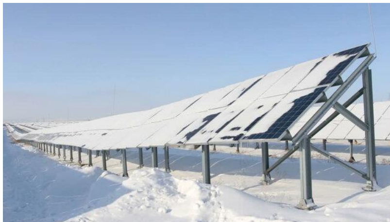
Слика 2.7.2.2. Соларни панели залеђени и покривени снијегом 38
