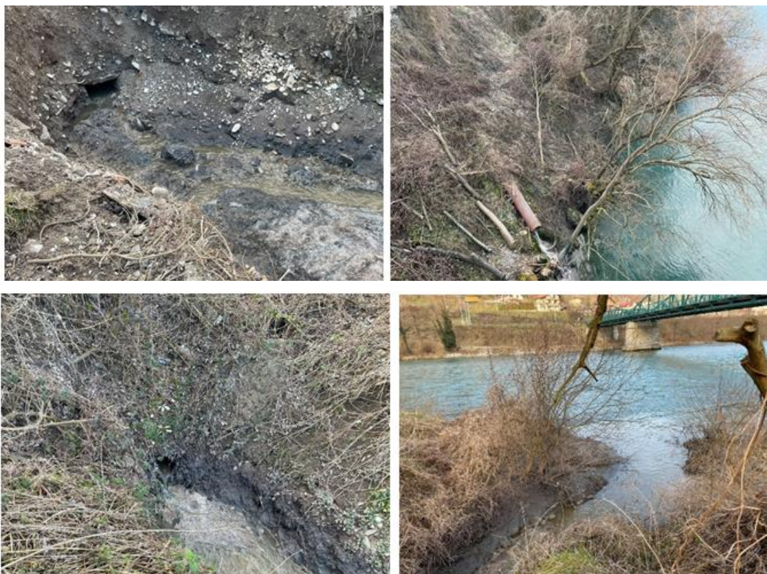
Слика 2.1.11.3.5. Фото записи 04.02.2025. слике горе - канализациони испусти бр.3 и 4 и слика доле - кан. испуст бр.2. код моста 9. Мај на р. Дрини
