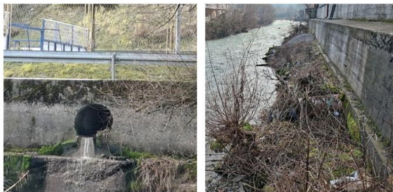
Слика 2.1.11.3.7. Фото записи 04.02.2025. канализациони испусти на р. Ћехотини, слика лијево - испуст бр.4 и десно - испуст бр.6
